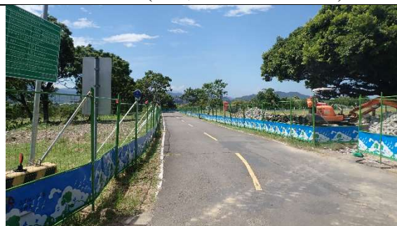
照片 6：工地設置圍籬及施工告示牌 (拍攝日期：109.08.21)
