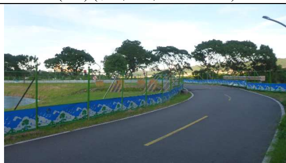
照片 4：利用現有道路做為施工道路無另闢施工便道(拍攝日期：109.08.21)
