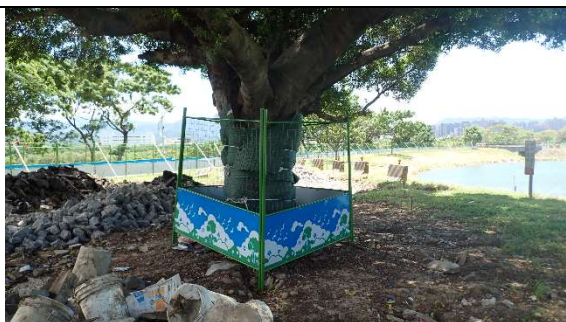
照片 8：保全大樹-榕樹於施工期間設置圍籬及樹身包覆保護(拍攝日期：109.08.21)
