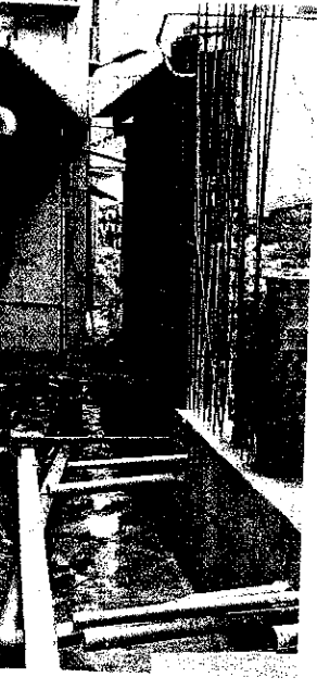
三重洛陽街49巷的汙水接管工程因故延宕多時，造成化糞池排水不通，水溝臭氣薰天，居民苦不堪言。（記者賴筱桐攝）
