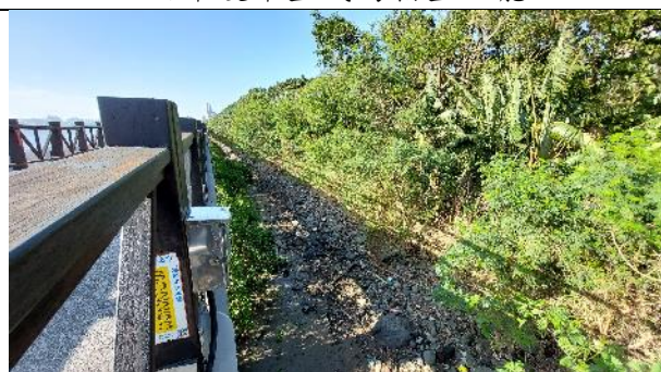
自行車道高架段陸側為自然的土坡環境
