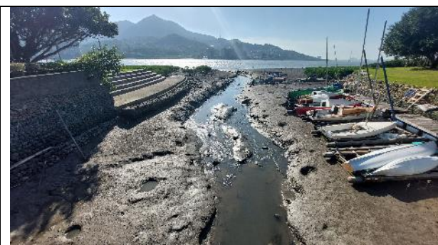
樹梅坑溪自行車道下游環境-右岸護岸為箱型石籠，左岸為石籠及混凝土景觀台
