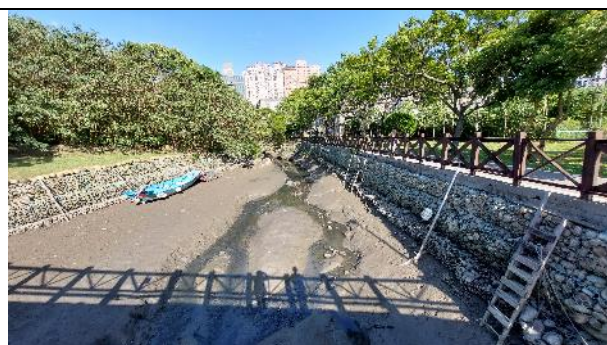
樹梅坑溪自行車道上游環境-兩岸護岸型式為箱型石籠
