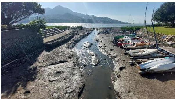
樹梅坑溪自行車道下游環境-右岸護岸為箱型 石籠，左岸為石籠及混凝土景觀台
