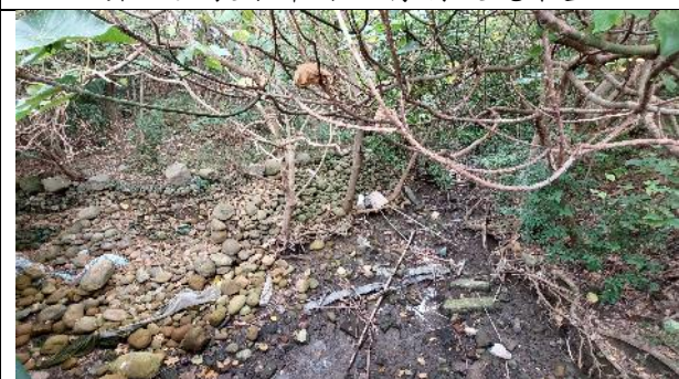
排水路兩側生長先驅樹種並在林下形成遮蔭環境，護岸型式包括石籠及自然土坡
