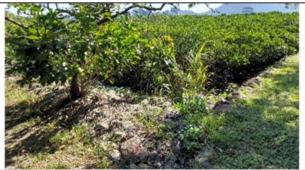
石籠及砌石護岸環境
